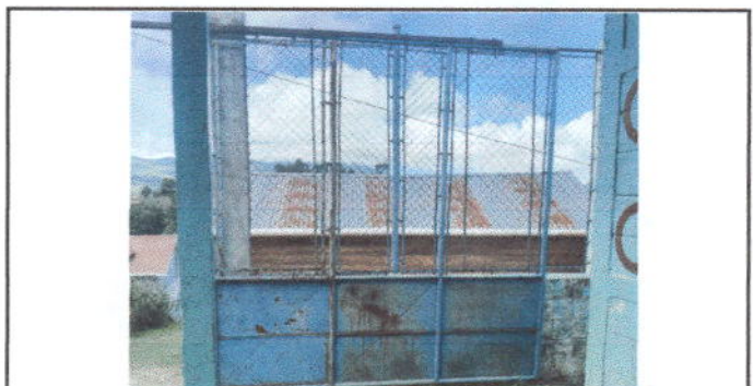
Foto 6: mantenimiento a portones de metal
