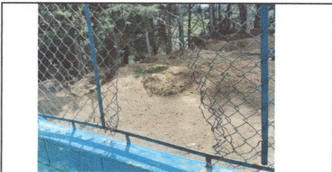
Foto 5: Reparacion de tubo hg y malla galvanizada
