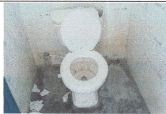
Foto 2: Sustitucion de inodoro
